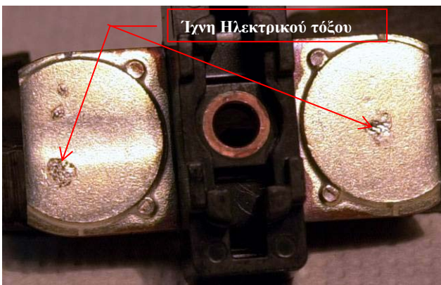
Φωτ. 11. Ηλεκτρονόμος ισχύος μπαταρίας
